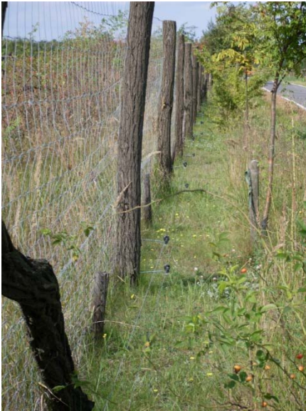
Abbildung 9: Eine zusätzlich, mit zwei an Langisolatoren befestigte Elektroleiter, gesicherte Stabilzaunanlage (Foto: Klingenberg)
